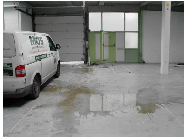
Trans 5, boring 13 (geheel rechts) en peilbuis 12
