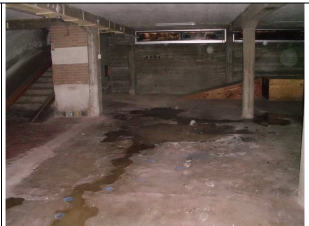
Trans 6 kelder, boring 19 (opgang linkerzijde)
