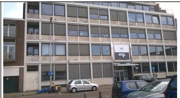
Trans 5-6, gezien vanaf het parkeerterrein
