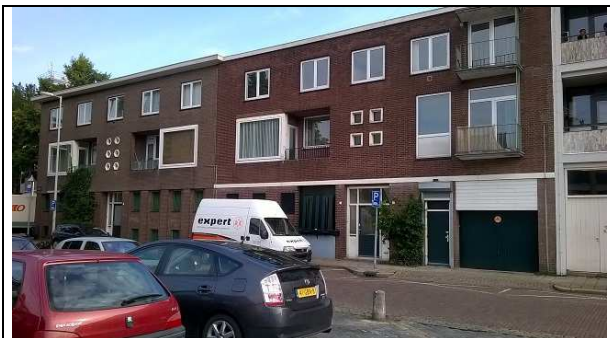
Trans 1-4, gezien vanaf het parkeerterrein
