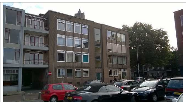
Trans 9-11, gezien vanaf het parkeerterrein
