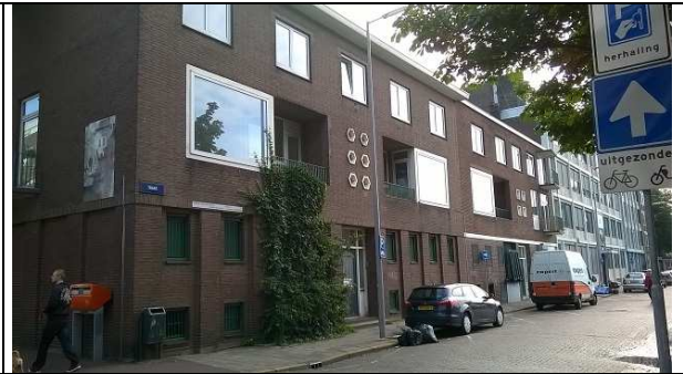
Trans 1-6, gezien vanaf de Nieuwstraat
