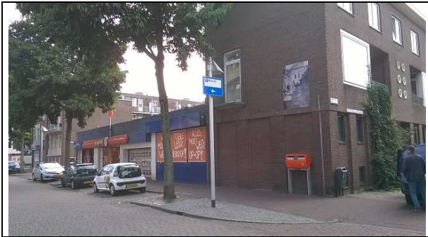
Hoek Trans 1 / Nieuwstraat 25
