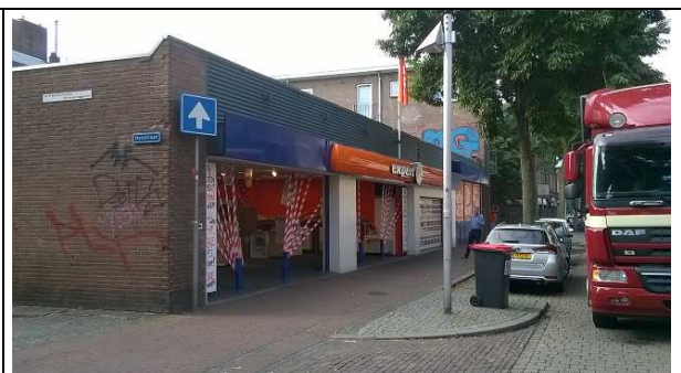
Nieuwstraat 25 ('Expert') en toegang Helstraat (links)
