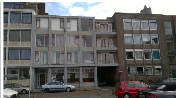
Trans 7-9, gezien vanaf het parkeerterrein
