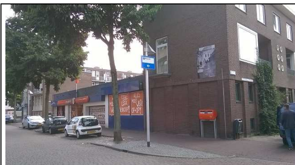
Hoek Trans, Nieuwstraat
