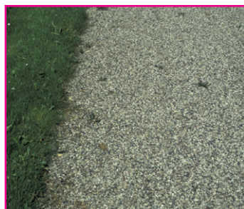
Paden; halfverhard met smalle kantopsluiting
