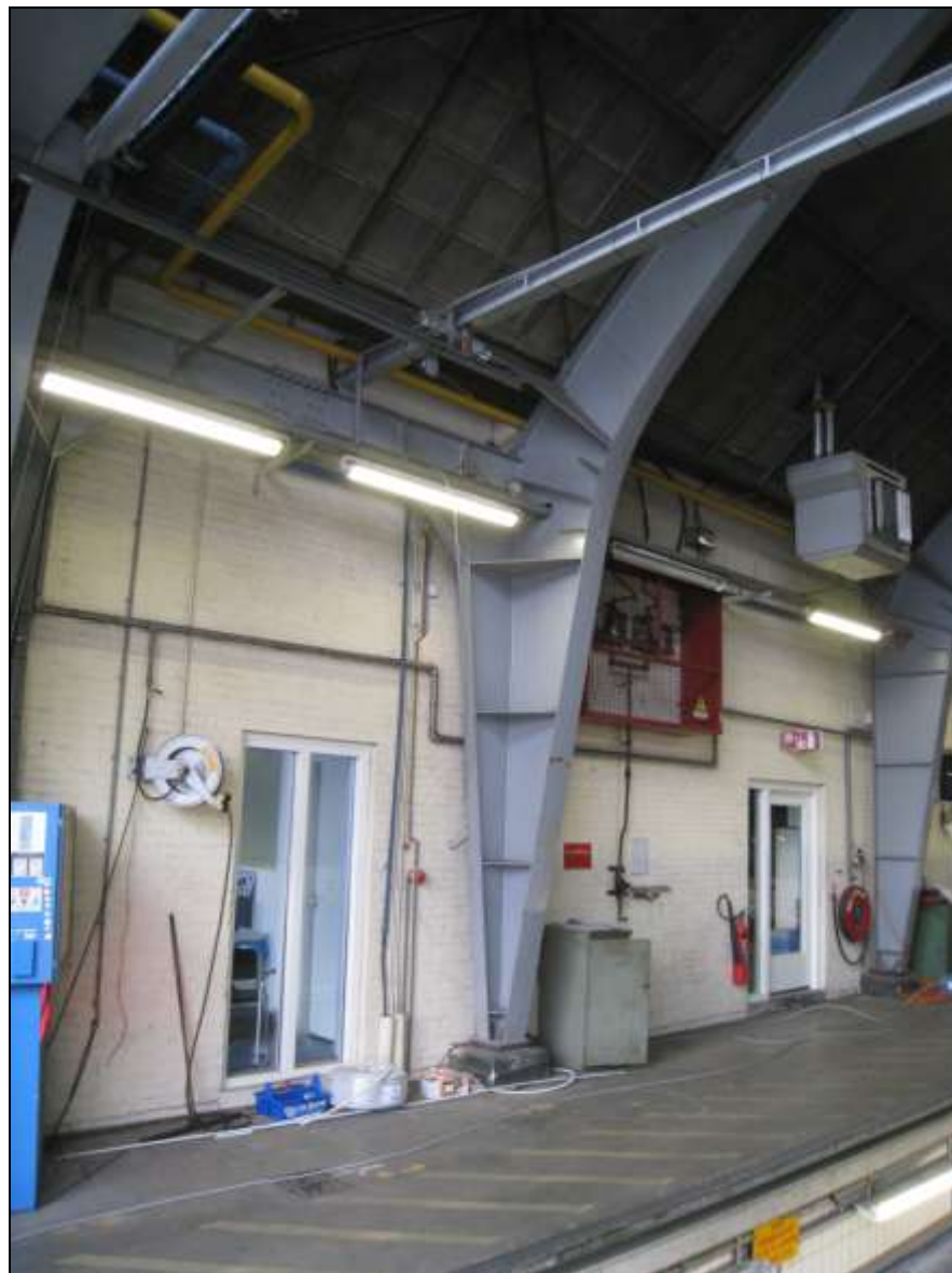
afb. 3 Zicht op de stalen spantconstructie.
