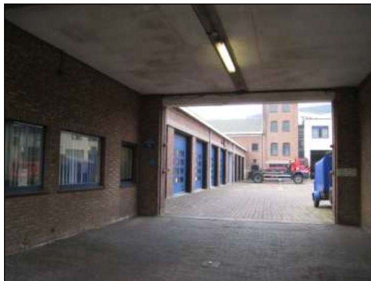
afb. 42 Toegang tot het binnenterrein met de brandweerremise.
