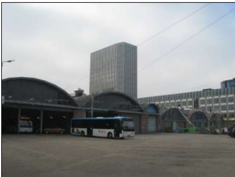
afb. 1 & 2 Opnames aan de noordzijde van de remise.
