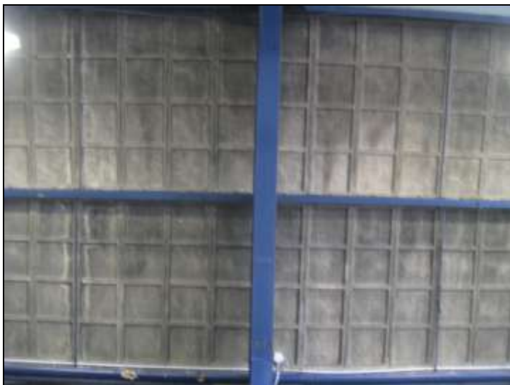
afb. 8 Betonnen kap met cassettes.
