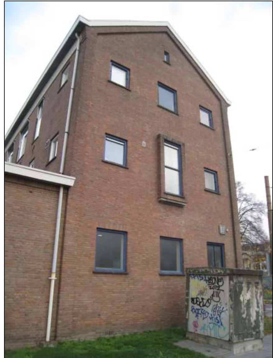
afb. 38 Kopgevel van het voorste bouwdeel.
