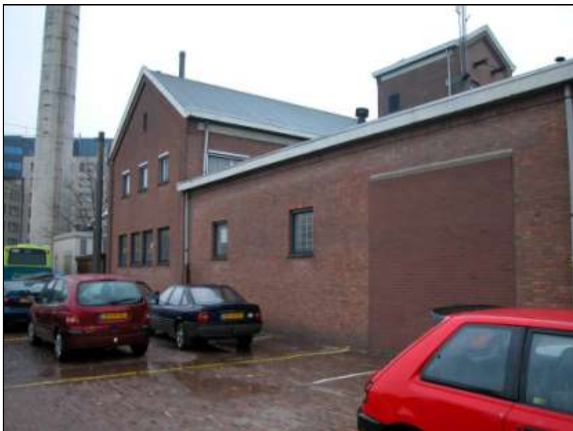
afb. 51 Brandweerremise (rechts) en verbindingslid met slangentoren (2004).
