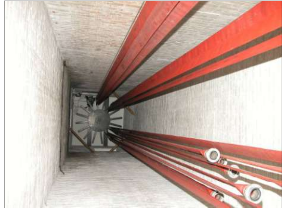
afb. 53 & 54 In- en exterieur van de slangentoren (2004).
