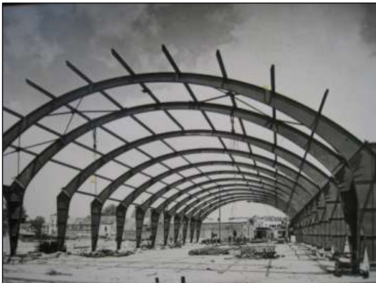
afb. 4 Eén van de remisehallen tijdens de bouw.
