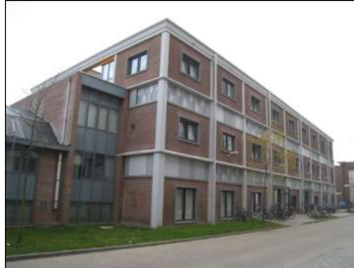
afb. 20 Linker hoekaanzicht, met aansluiting op het remisegebouw.
