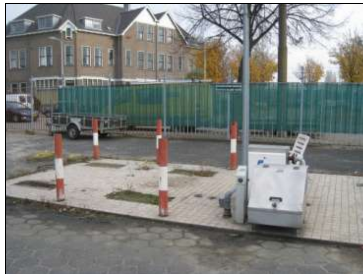
afb. 16 Voormalig bordes van een service- of pompinstallatie.
