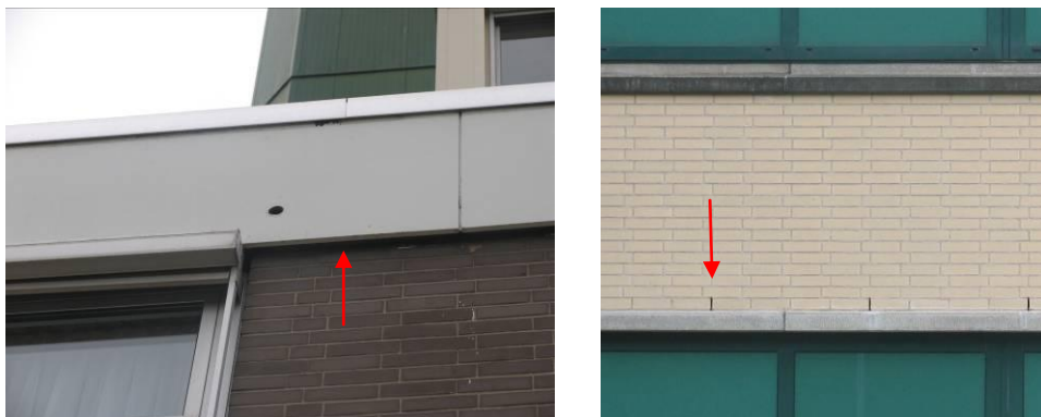
Afbeelding 4: mogelijke toegangen tot verblijfplaatsen van vleermuizen.
