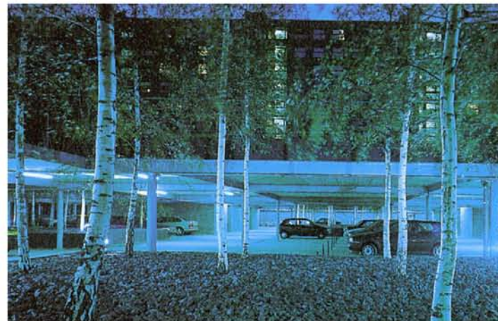
Referentie parkeergarage en dekopening
