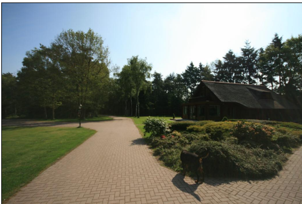
Figuur 5.10. Locatie B: het woonhuis gezien vanuit het zuiden.
