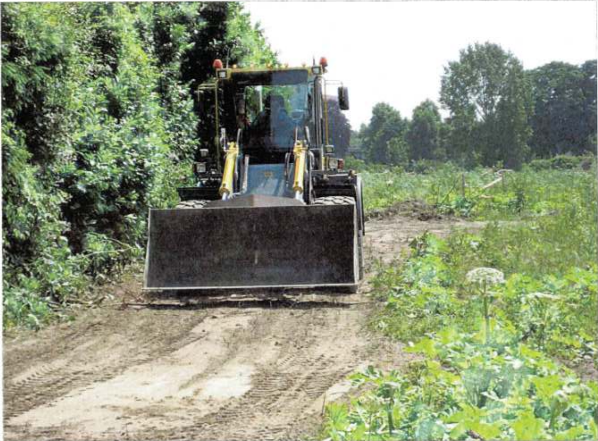
Bouwweg aanschuivende machine.
