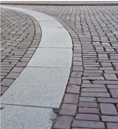
verlaagde betonnen band
