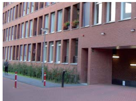
entree parkeergarage achter gevel
