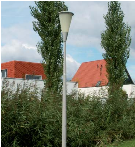
verlichtingsarmatuur 4 m hoogte
