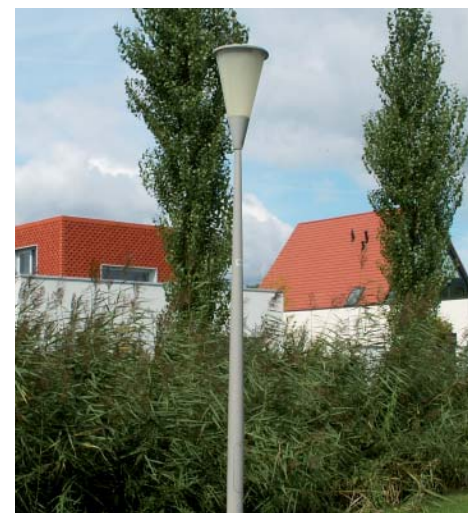
verlichtingsarmatuur 4 m hoogte
