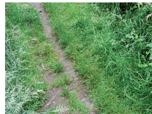
Oude klinkers opgraven en hergebruiken
