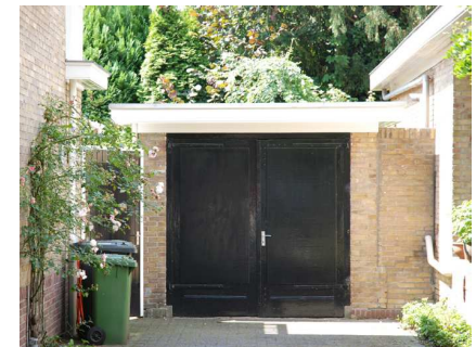
Bijgebouwen hebben een plat dak
