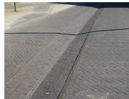
Brede goot in de weg t.b.v. het water
