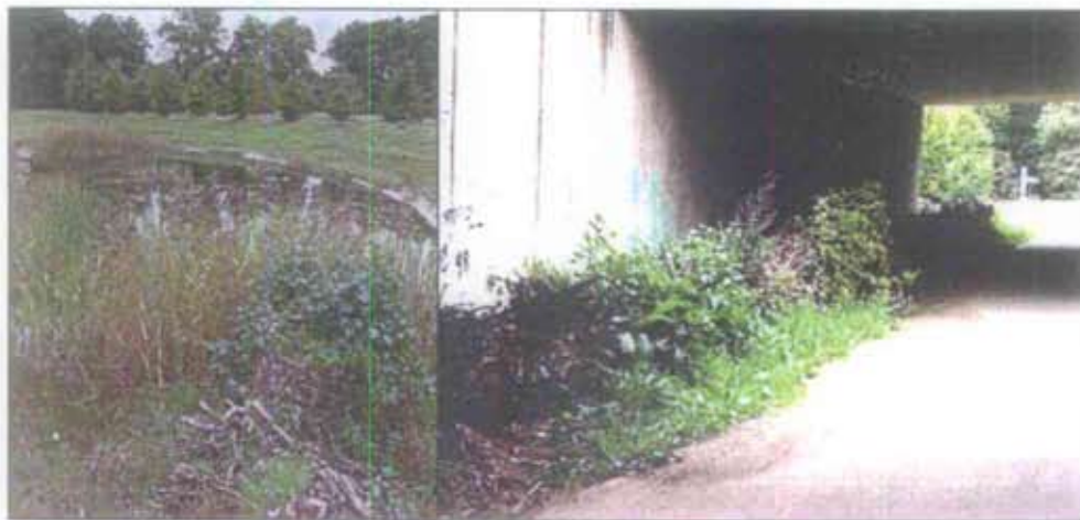
Figuur 2.6. Stobbenwal onder de A27 bij Hilversum, door de aanwezigheid van een amfibieënpool en houtstobben wordt dit viaduct regelmatig gebruikt door amfibieën.
