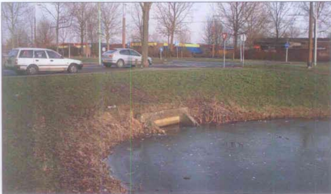
Figuur 3.2. Duikers in De Laar zijn voor terrestrische en semi-terrestrische soorten als amfibieën niet te passeren.
