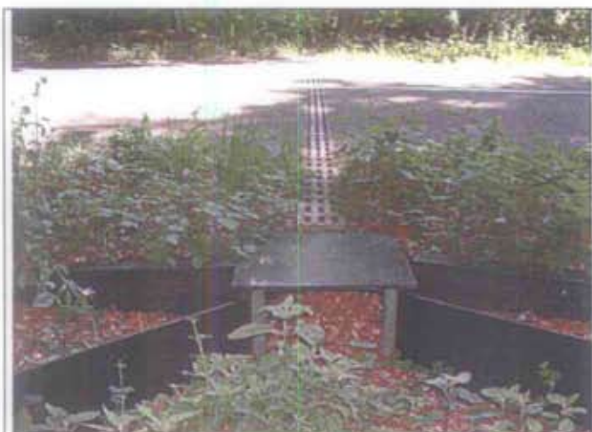
Figuur 2.3: Amfibieëntunnel bij Bergen.
