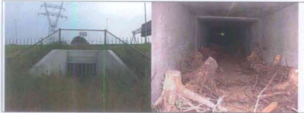
Figuur 2.4. Kleine faunatunnel onder de A1 bij Muiden, het talud rond de tunnel is verstevigd. Het traliwerk voorkomt het inkruipen van mensen; kleinere zoogdieren en amfibieën kunnen ongehinderd passeren. De binnenkant (90 x 70 cm) is voorzien van kleine stobben en grond.
