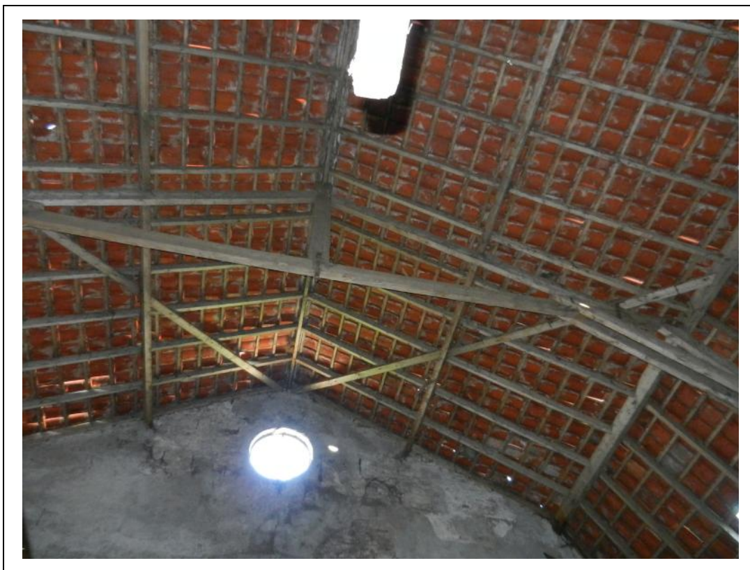
Foto 4. Zolderruimte boven de deel.
