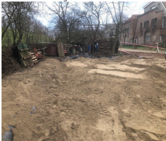
Foto 8 locatie afgewerkt met schoon zand
