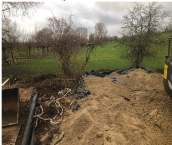
Foto 5 aanbrengen doek en schoon zand
