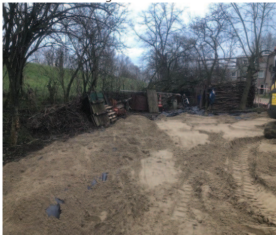
Foto 6 locatie afgewerkt met schoon zand
