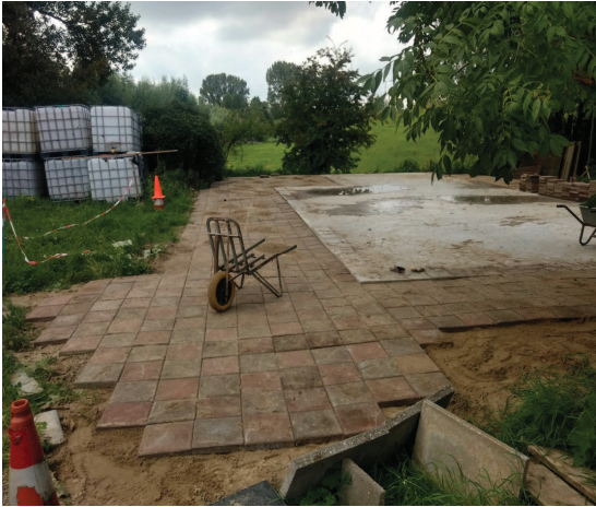
Foto 9 aanbrengen tegelverharding
