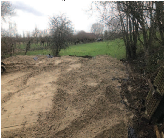
Foto 7 locatie afgewerkt met schoon zand
