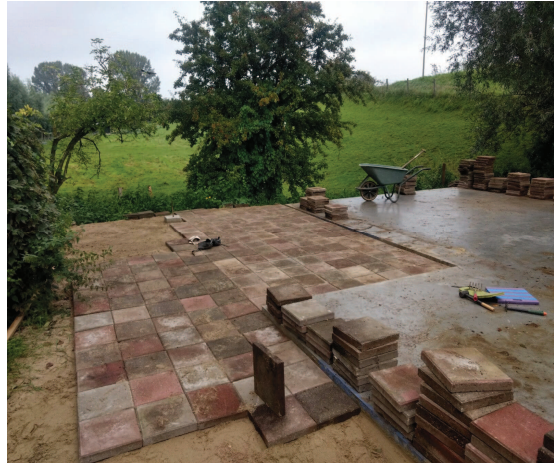
Foto 10 aanbrengen tegelverharding
