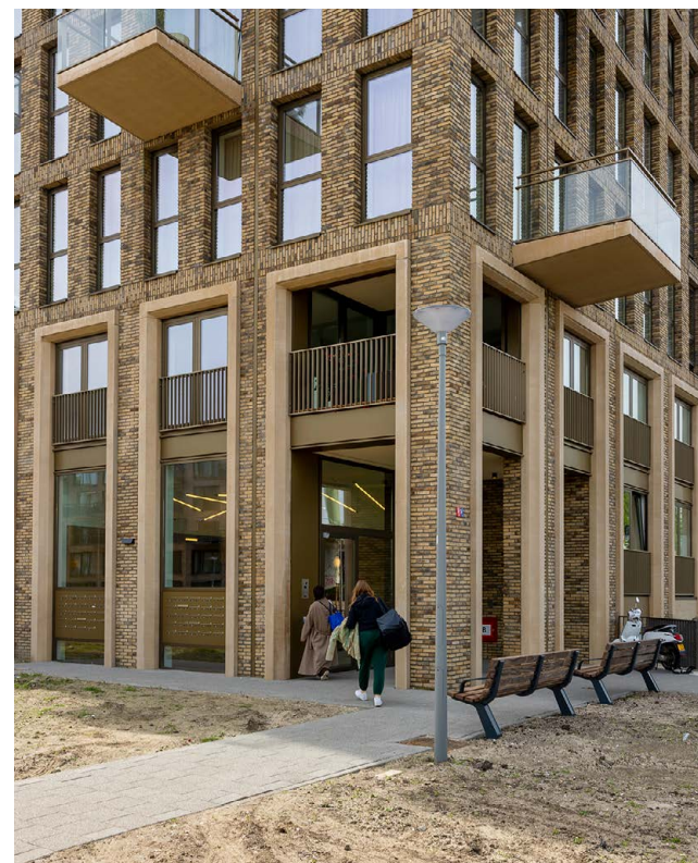
Elk gebouw zijn eigen geaccentueerde entree (Samen aan de Schie, WeArchitects, Rotterdam)
