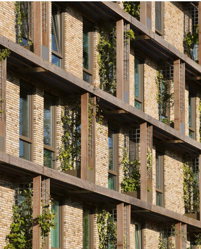
Dieptewerking frame benadrukt bovenbouw (De Veluwe Proeftuin, MIX architectuur, Ede)
