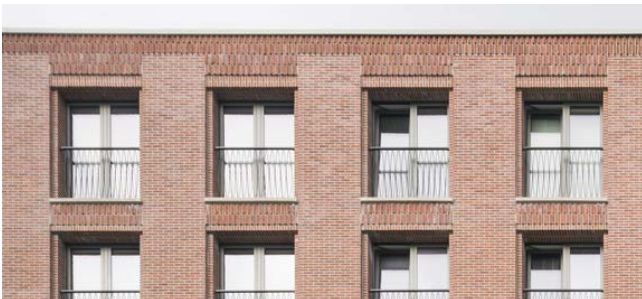
Beëindiging van gebouw met metselwerk (Tandt-D, Sergisonbates, Brussels)
