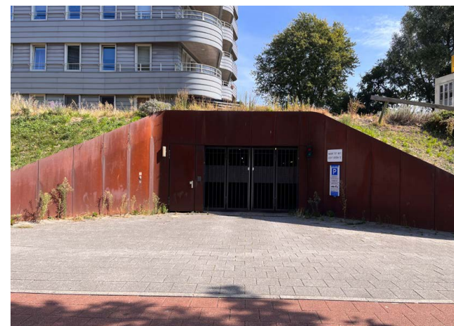
Parkeergarage deur met gaten (Amsterdam West)
