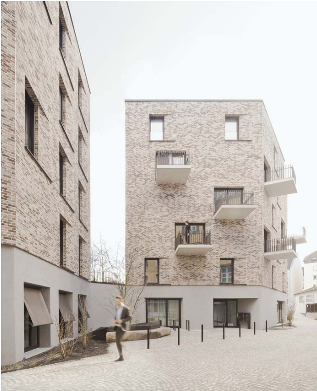
Subtiel materiaal verschil in onder- en bovenbouw (Steimle Architekten, Ludwigsburg)
