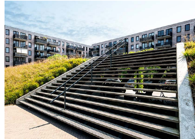
Trappartijen met ventilatie voor garage (De Evenaar, Amersfoort)
