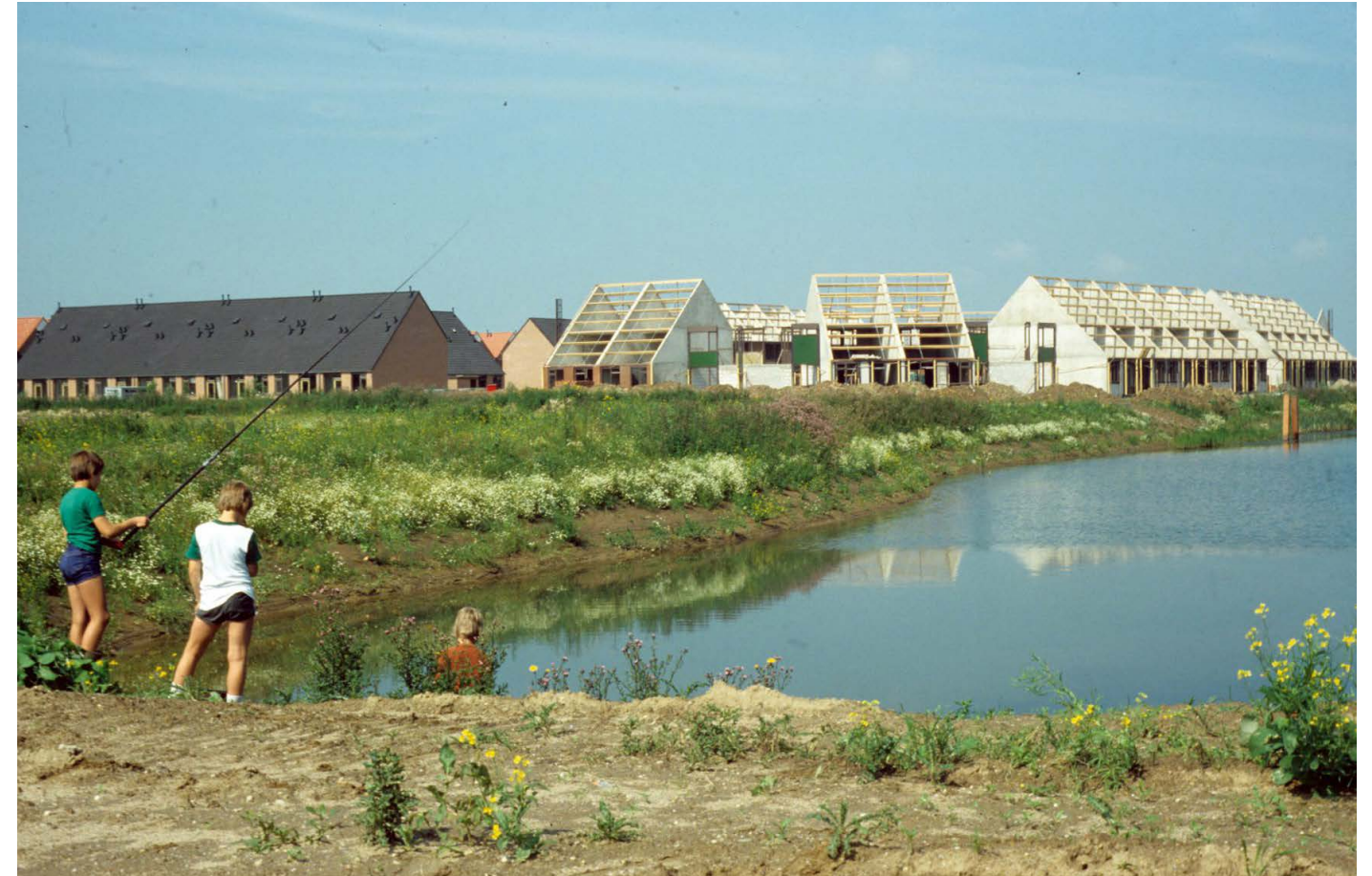
Bouw van de Laar West vanaf Ravensteinpad, Arnhem, 1980 (Gemeentelijk Archief)
