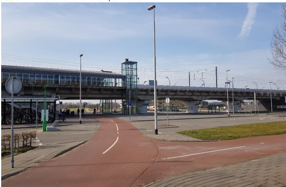
Foto 1. Situatie rondom het spoorviaduct
