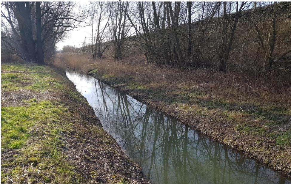
Foto 13. Gradienten in het zuidelijk deel: sloottaluds en spoortalud
