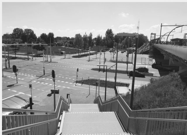
Huidige situatie vanaf stationstrap
