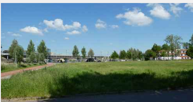
Zicht vanuit De Laar naar het spoorviaduct
