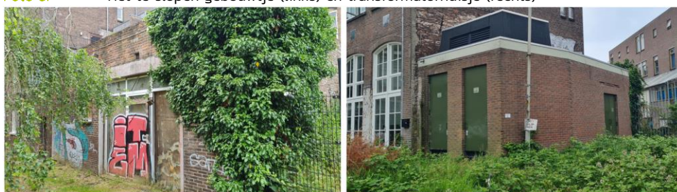
Foto 3. Het te slopen gebouwtje (links) en transformatorhuisje (rechts)
