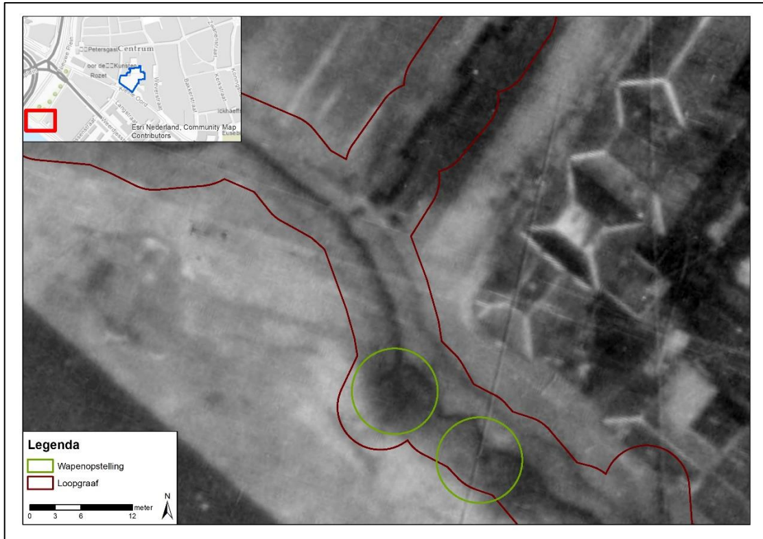
Afbeelding 10: aan de noordoever van de Rijn werden loopgraven en wapenopstellingen waargenomen. Deze lagen volledig buiten het onderzoeksgebied Bartokplein te Arnhem (Gelderland). Bron: WAG, sortieref. 16-1803, fotonr. 4040, d.d. 19-01-1945.
